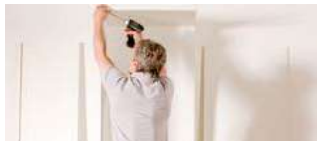
Tenere il cacciavite a batteria pronto e avvitare sull'angolo anteriore. In tal modo è possibile effettuare il montaggio con un unico operatore.
