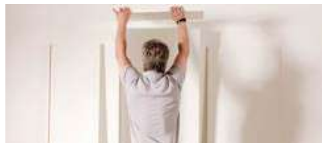
Posizionare il cappello e allinearli alla spalla laterale del mobile.
