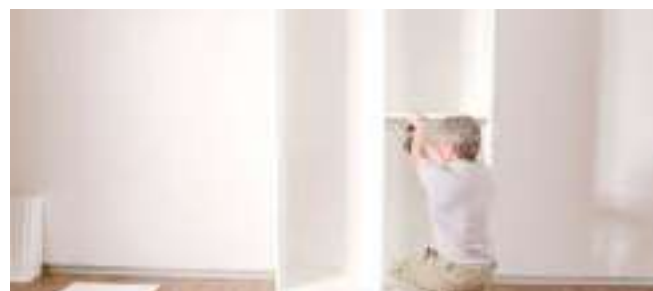
Suggerimento: - Posizionare il ripiano in corrispondenza dei fori e avvitare prima da un lato e poi dall'altro. - Le viti sporgenti facilitano il montaggio.
