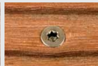
Preforatura + vite Terrasotec
